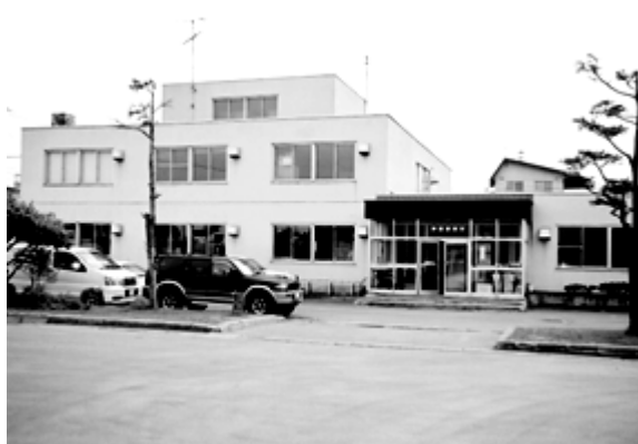
クリーンセンター管理事務所
