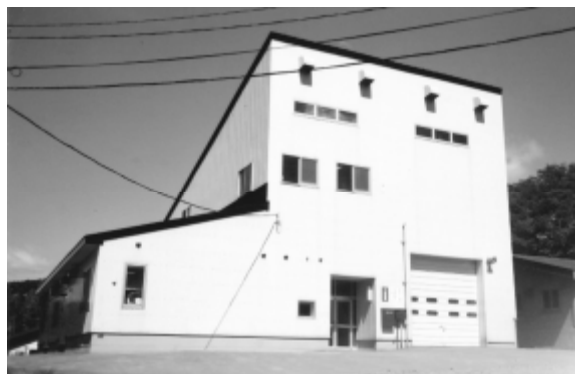
汚水高度処理施設
