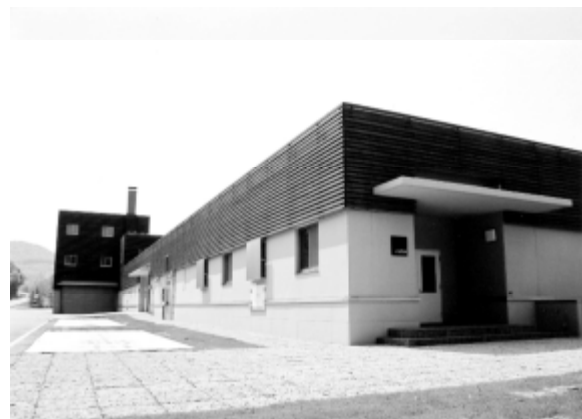
汚水処理施設
