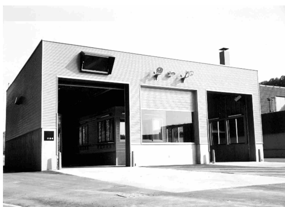
廃棄物処分場料金所
