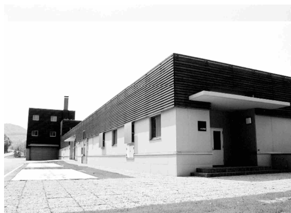
汚水処理施設
