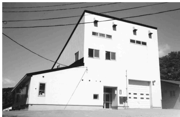
汚水高度処理施設
