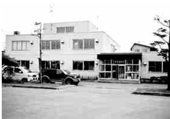
クリーンセンター管理事務所
