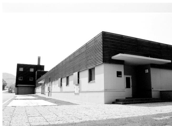
汚水処理施設
