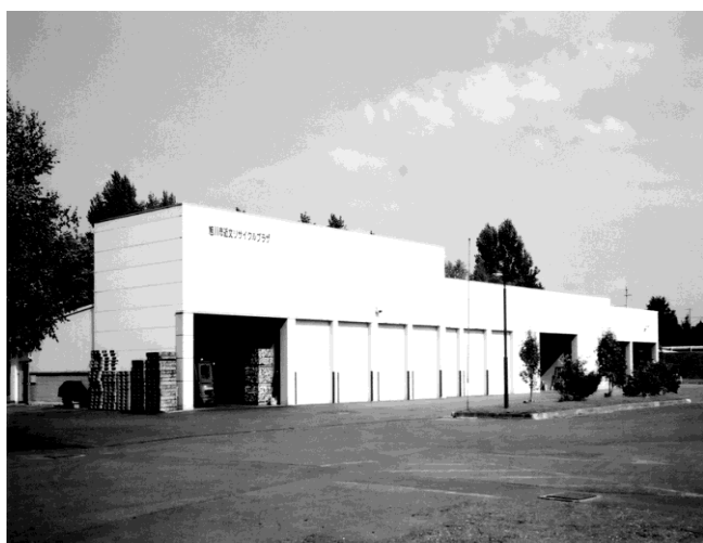
【旭川市近文リサイクルプラザ】
