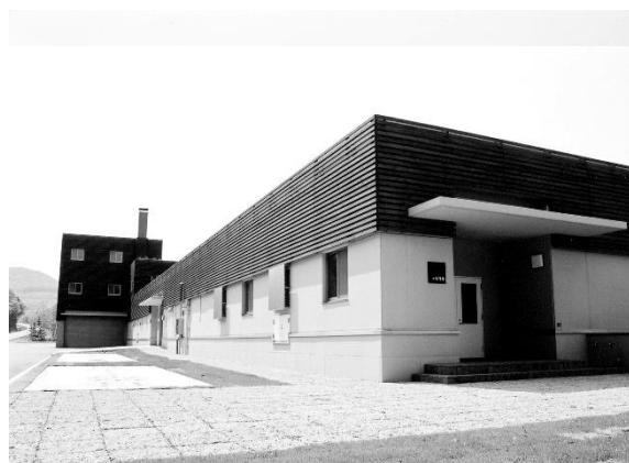
汚水処理施設
