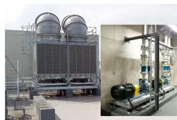
入院病棟冷却塔更新工事
