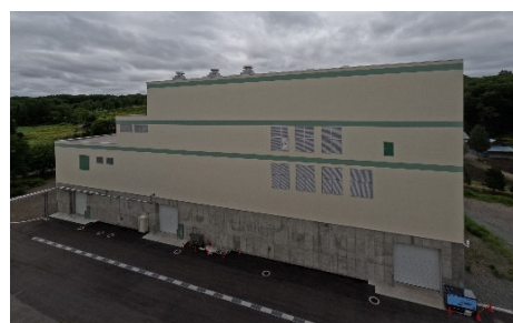
1号汚泥焼却施設
