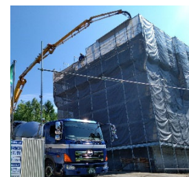
高砂台調整池建設時の様子
