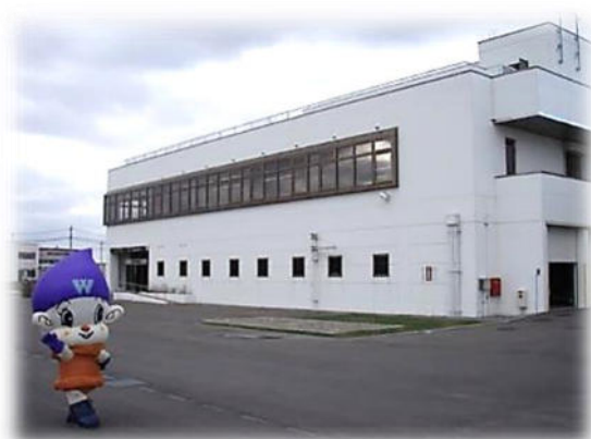
《忠別川浄水場》
