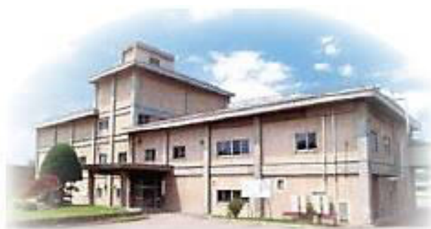
《亀吉雨水ポンプ場》
