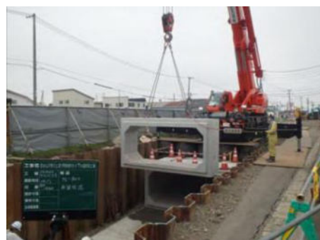
《雨水幹線の整備》
