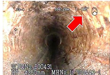
«腐食が進み、鉄筋が露出した管»
