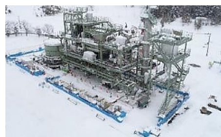
◀1号汚泥焼却施設の建替▶ (下水処理センター)
