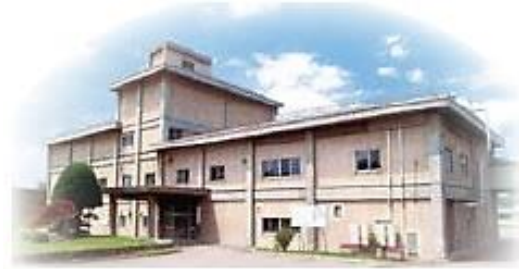
《亀吉雨水ポンプ場》
