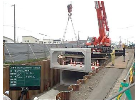
《雨水幹線の整備》
