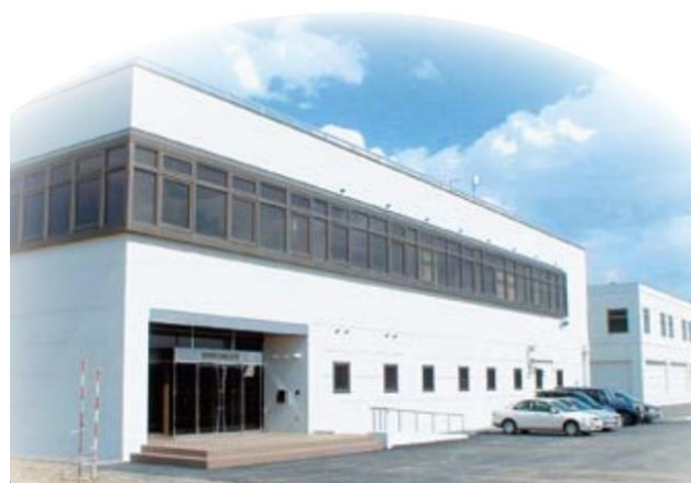
《忠別川浄水場》
