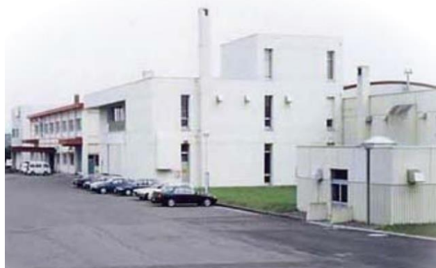
《石狩川浄水場》
