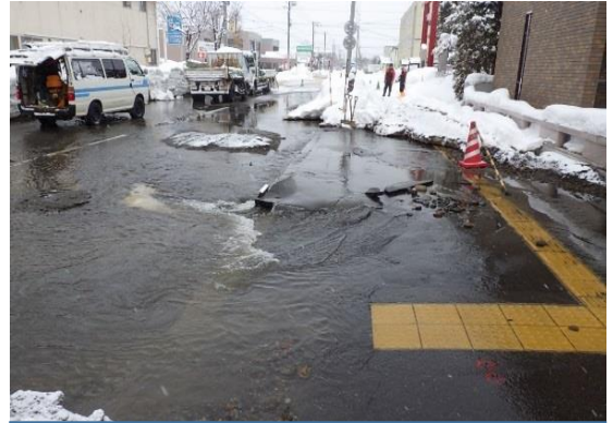
【本市で発生した漏水】
