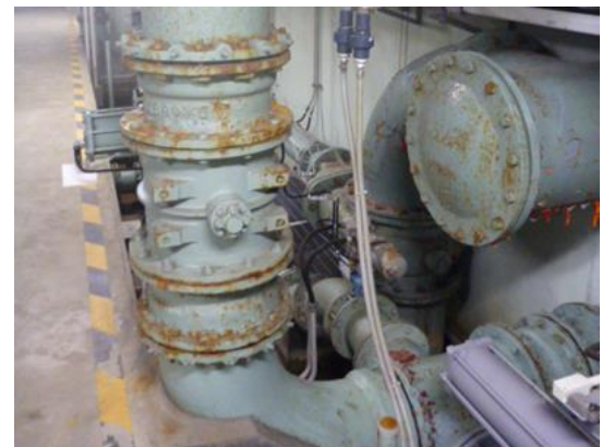
【石狩川浄水場のろ過池洗浄設備】
