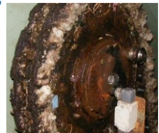
最初沈殿池 かきよせ 汚泥掻寄機 （下水処理センター水処理棟）※写真は設備の一部 平成2年度設置、28年使用（目標耐用年数25年）
