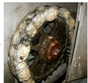
最終沈殿池 かきよせ 汚泥掻寄機 （下水処理センター水処理棟）※写真は設備の一部 昭和62年度設置、31年使用（目標耐用年数25年）
