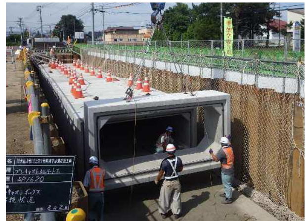
【雨水 かんきよ 函渠新設工事の様子】
