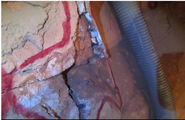
No.1 汚泥焼却炉（内部の状態） （下水処理センター焼却炉棟） 平成7年度設置，23年使用（耐用年数10年）
