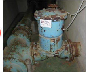
ろ過池洗浄設備(石狩川浄水場横流式沈殿池) 昭和54年度設置, 39年使用(耐用年数16年)
