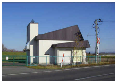
東旭川ポンプ場
