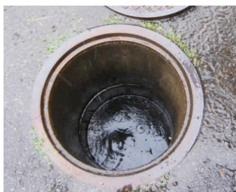
污水管内部が不明水で浸ってしまった状況
