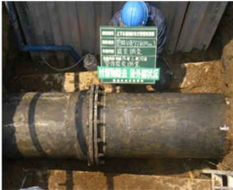
配水管老朽度調査
