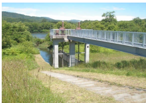
下水処理センター放流渠（吐口樋門）
