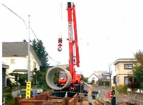
雨水幹線の整備
