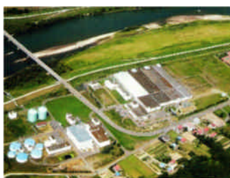
下水処理センター全景
