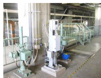
汚水処理施設
