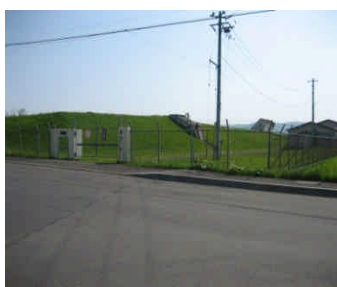
千代ヶ岡配水場
