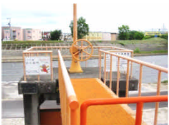
水道局が管理する排水樋門の一つ（牛朱別川左岸の17丁目排水樋門）
