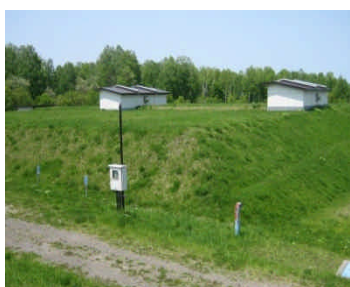
三角台配水場
