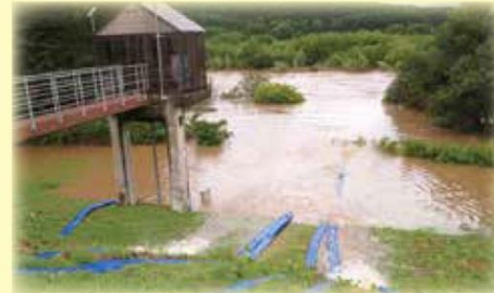
(排水ポンプによる雨水排除)
