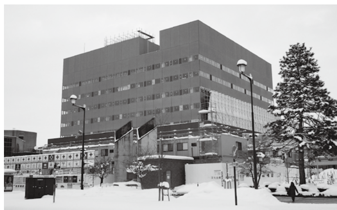
▲地上から見た建設中の新庁舎（令和4年12月時点）
