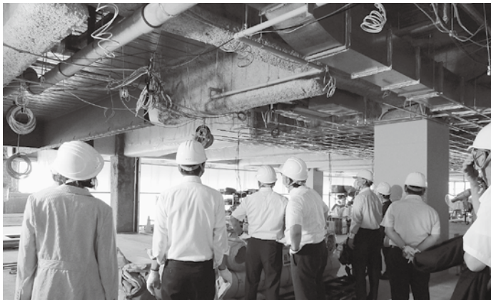
▲建設中の新庁舎内部を見学する議員
