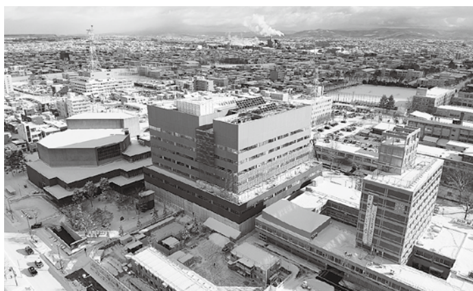
▲空から見た建設中の新庁舎（令和4年12月時点）
