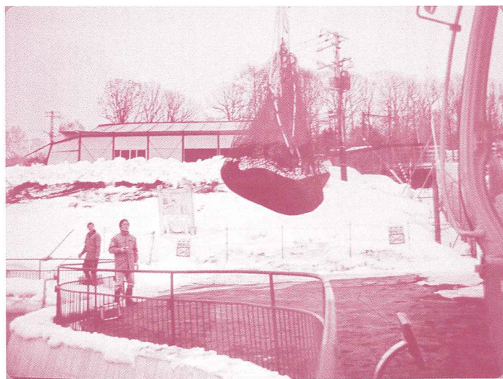
つり上げてトラックに積み込む様子
