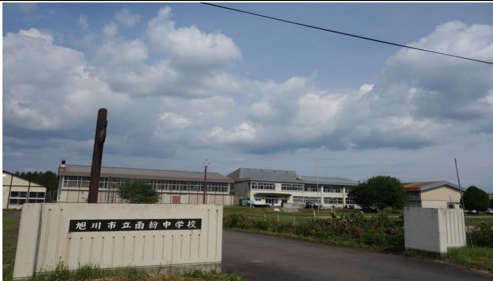
写真2 建物の立地環境が見えるもの(○印は渡り廊下, 合併浄化槽)
