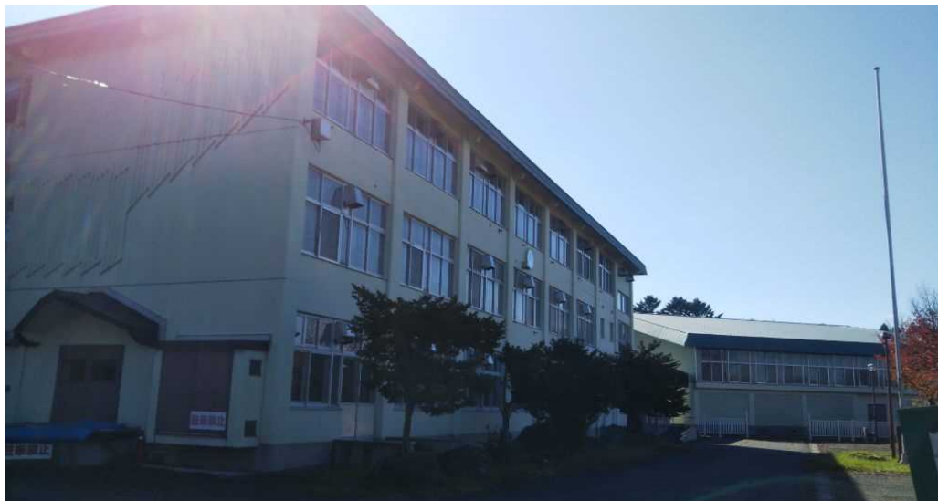
写真2 建物の立地環境が分かるもの
