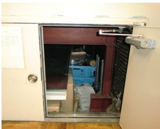
備蓄品などで庫内が埋め尽くされた状態。 人が入るスペースがほとんどない。
