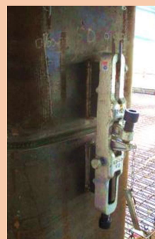
溶接前はこの器具で固定しています。
