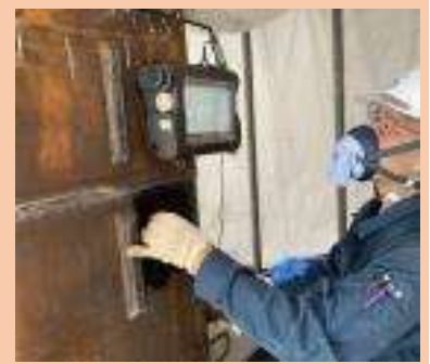
溶接後は、施工部分全てに、超音波で不良部分を探す検査を行います。
