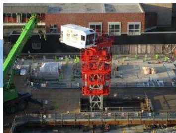
②マストの上に運転室を設置します
