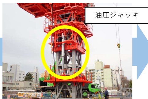
②油圧ジャッキが、いも虫のように伸縮しながら昇っていきます。 (1分間で約60cm上昇します)
