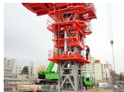
②油圧ジャッキが、いも虫のように伸縮しながら昇っていきます。 (1分間で約60cm上昇します)
