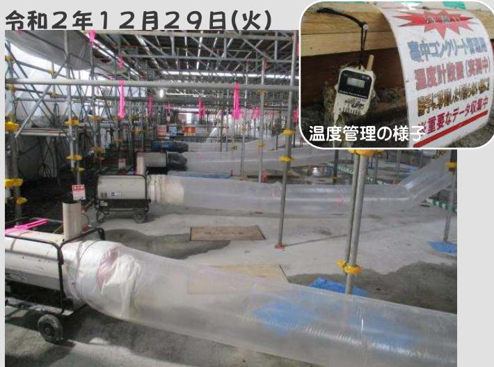
コンクリートが寒さの影響を受けないように、シートの覆いの中は温風を流したチューブが並んでいます。内部の温度を適切に保ち、コンクリートがしっかりと固まるよう管理しています。
