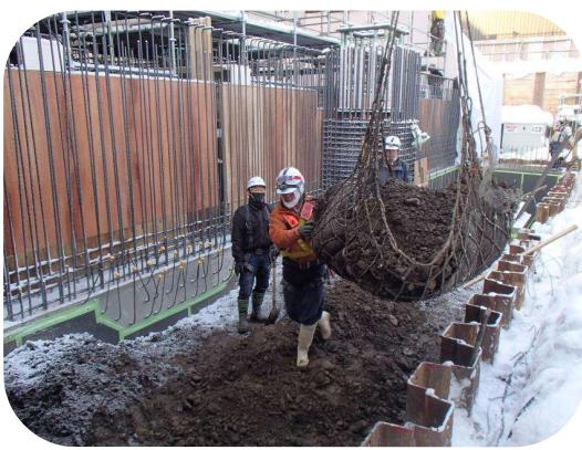
写真は、基礎と土留めの間を土で埋めている様子で、クレーンを利用して土の運搬を行っています。
