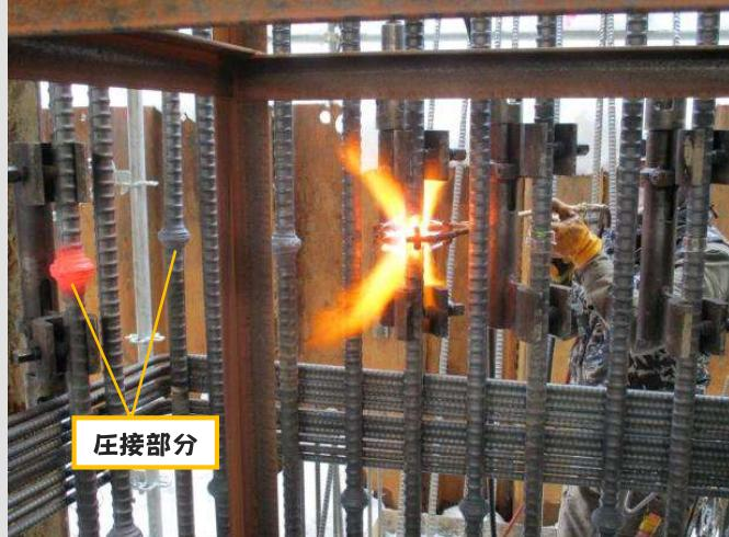
2本の鉄筋をつなげて一本化する圧接(あっせつ)の状況です。鉄筋同士を押しつけ合いながら溶接します。真っ赤になっている部分は圧接したてです。
