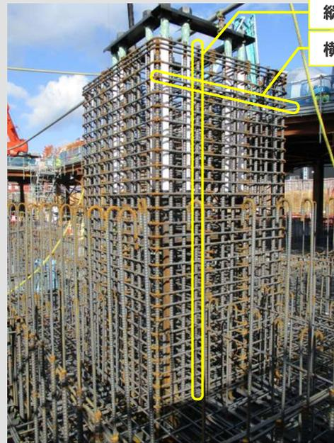
基礎の鉄筋をアンカーボルトの周りに組んでいる状況です。鉄筋の太さは縦の鉄筋が35mm、横の鉄筋が16mmもあるものを使っています。
