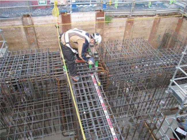
鉄筋には建物の位置ごとに間隔の指定があるため、メジャーを当て、正しい間隔で配置されているかを確認しています。
