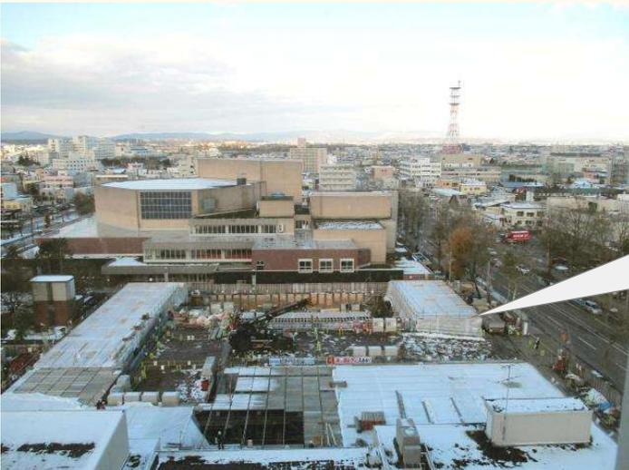
工事敷地内に白いシートの囲いが設置されました。これは、寒い時期にコンクリートを施工する場合に、コンクリートが寒さの影響を受けないよう暖房をし、適切な温度管理をするための囲いです。
