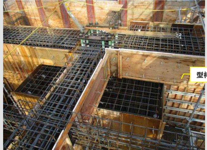
鉄筋の配置が終わると基礎の形に合わせて板で囲います。この板を型枠といいます。
