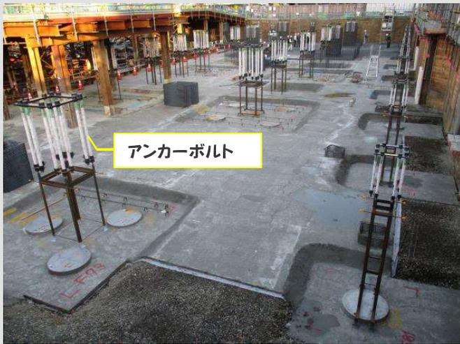
地上の構造と基礎を繋ぐためのアンカーボルトを設置したところです。アンカーボルトの頂部で1階部分の鉄骨の柱と接続します。
