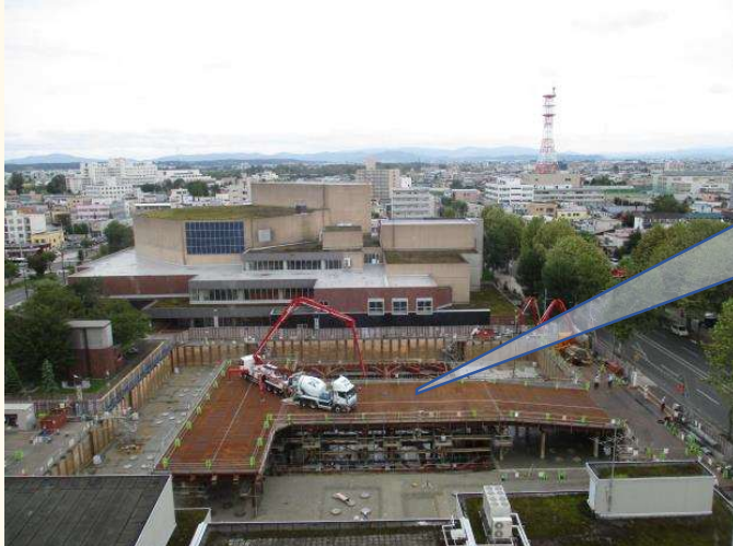
令和2年9月23日(水) 乗入構台組立完了 コンクリート打設*
