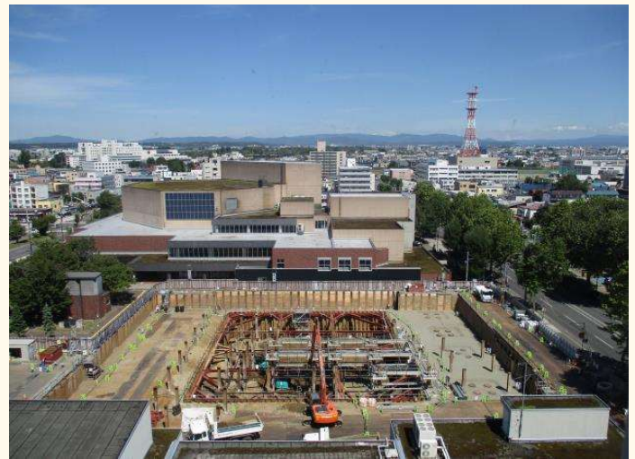
令和2年8月24日(月) 地下部分掘削
