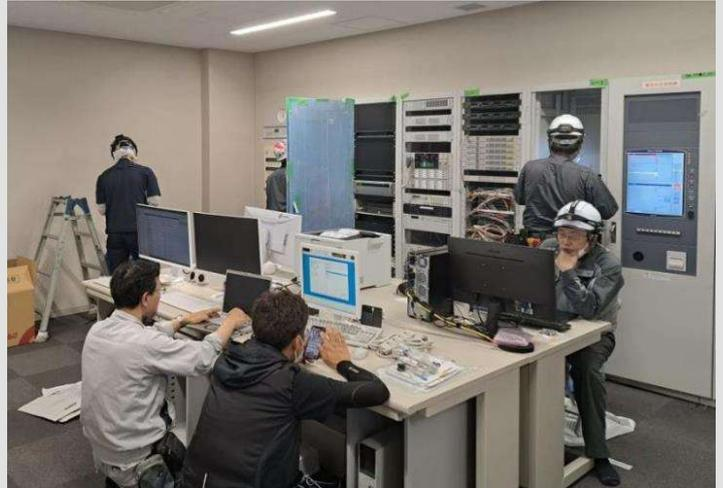
1階の警備室は、建物全体の監視・制御の設備が集約された維持管理の中核となるため、様々なシステムの技術者が設定・調整作業を行っています。
