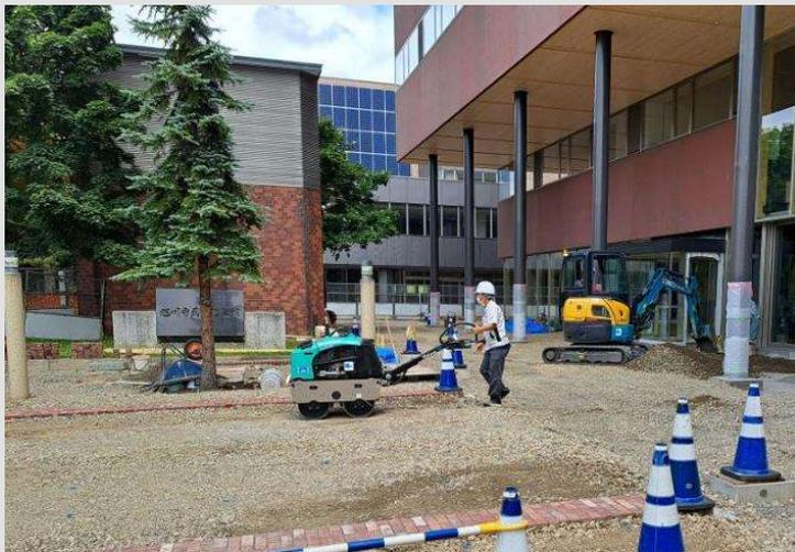
これまで工事の資材置き場だった場所の舗装工事を行っています。砂利を転圧機でしっかり締め固めた路盤の上に、アスファルトを敷いていきます。
