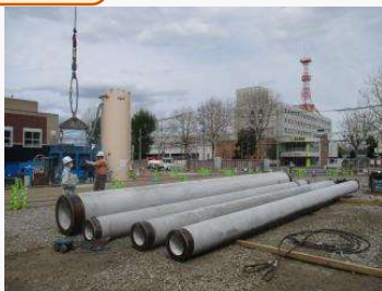
直径50㍉～90㍉の既製コンクリート杭
