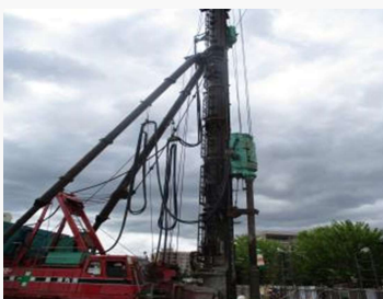
掘削作業で使用する掘削機(オーガ)
