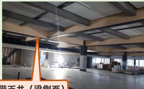
1,2階天井（梁側面）
