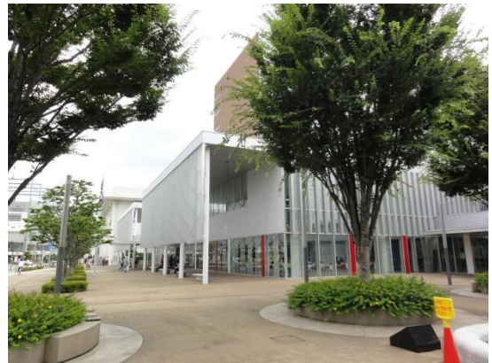
広場整備の事例（町田市役所）
