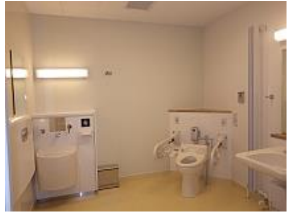
オストメイト併設の多用途トイレの事例 (旭川市東部まちづくりセンター)
