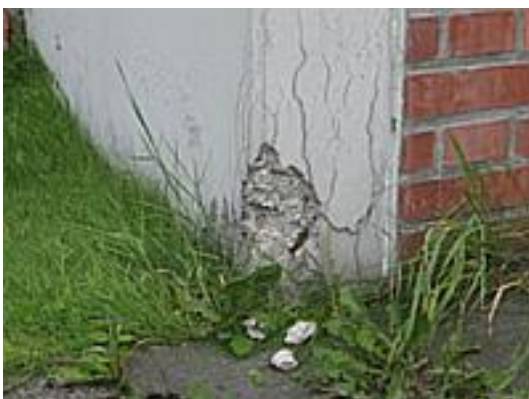
外壁コンクリート壁のひび割れ (総合庁舎外壁)
