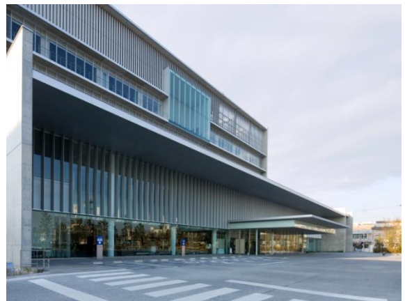
庇のある風除室横に車いす利用者用駐車場の事例 (西尾市役所)
