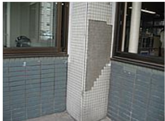
外壁タイルの剥落 (第三庁舎外壁)
