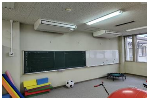
▲エアコン整備後の様子
