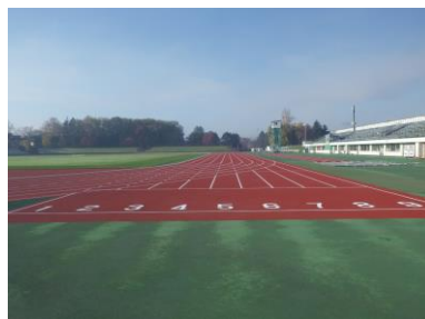
▲陸上競技場施工完了
