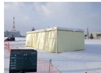
▲災害用あずまや施工完了
