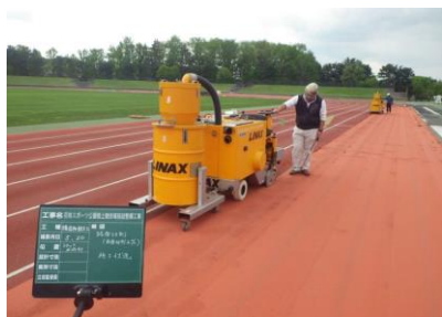
▲陸上競技場施工中
