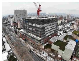
建設中の新庁舎
