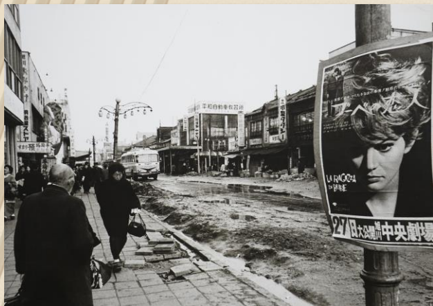
昭和40年(1965年)4月 寒さで傷んだ歩道(平和通り)
