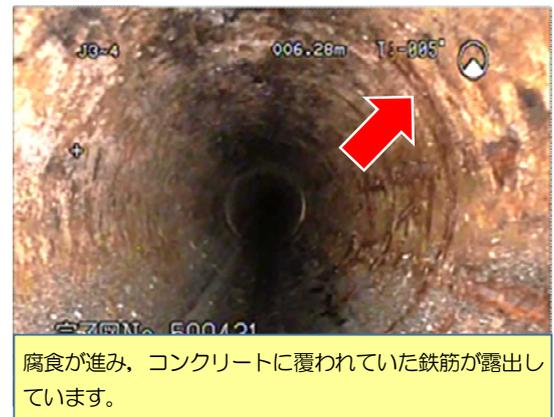
腐食が進み、コンクリートに覆われていた鉄筋が露出しています。
