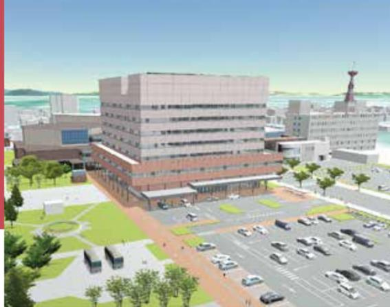
令和5年11月のオープンに向け、新庁舎の建設工事を進めています。工事は同2年4月に始まり、同5年8月までの41か月を予定しています。昨年4月から始まった鉄骨の組み立てが11月に完了し、現在は低層階の外壁工事を終え、冬期休止中です。今年3月から工事を再開し、夏には建物全体の外壁工事が終了する予定です。今回は進捗状況とともに、9階建ての新庁舎を支える鉄骨の役割を紹介します。
