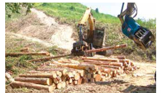
旭川市森林組合による伐採作業
