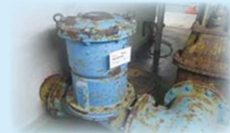
ろ過池洗浄設備（石狩川浄水場横流式沈殿池） 昭和54年度設置、41年使用（耐用年数16年）
