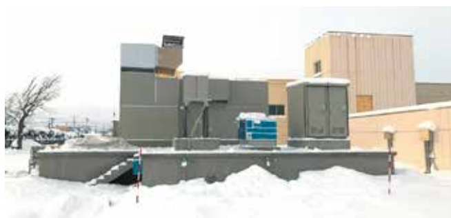
石狩川浄水場非常用自家発電設備（工事中）
