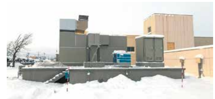
石狩川浄水場非常用自家発電設備(工事中)
