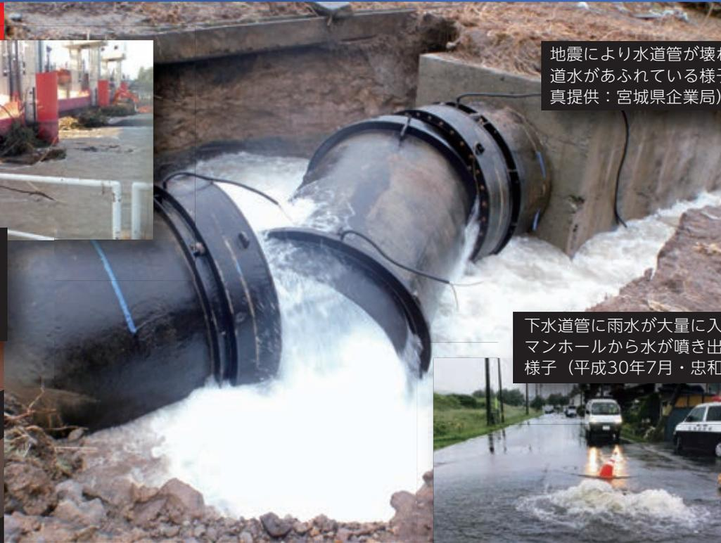
地震により水道管が壊れ、水道水があふれている様子（写真提供：宮城県企業局）
