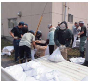
地域の人たちによる土のう整備
