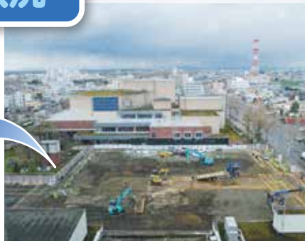
新庁舎の建設地の周囲に、安全フェンスを設置しました（4月撮影）
