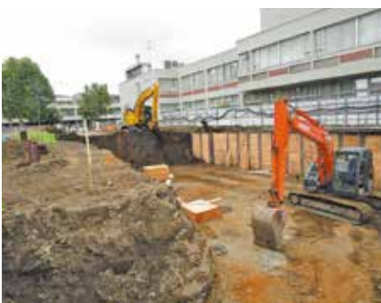
基礎と地下部分の掘削工事を実施。一番深い場所では、地面を8.4mの深さまで掘削しました（7月撮影）
