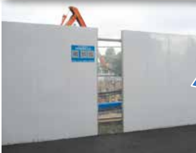
工事を見学できるように、安全フェンスの一部に見学窓を設置しています
