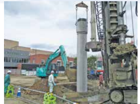
新庁舎を地下14.5mにある頑丈な地盤で支えるため、杭を埋め込みました（5月撮影）
