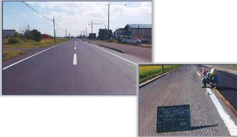
この工事は、老朽化した舗装表面の一部を削り取った上で、その上に新たな舗装を行う「オーバーレイ」工事ですが、良好な出来形管理により、路面の平坦性が改善し、快適に走行できる道路舗装に生まれ変わりました。
