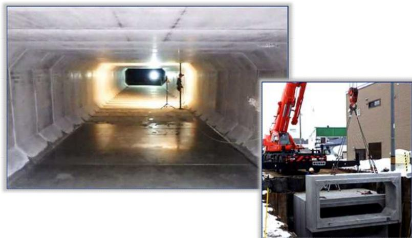
この工事は、開水路を函渠（ボックスカルバート）で暗渠化するものです。住宅のすぐ近くで鋼矢板による締切を行い、クレーン車で函渠を吊り上げて設置するなど、十分な安全対策が求められましたが、適正に施工されました。
