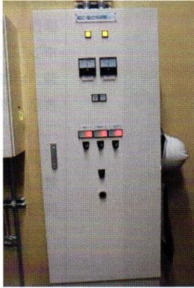
システム・電灯主電源、温水一次側、二次側ポンプ手動運転および運転状態表示、システム異常時ランプおよびブザー連動警告
