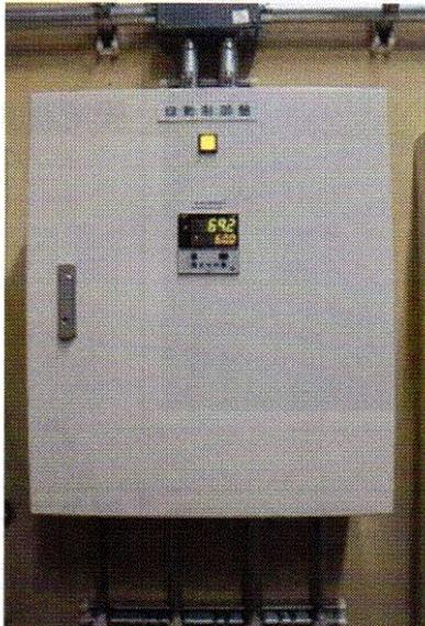
蓄熱槽温度表示、施設側熱供給開始および停止温度の設定
