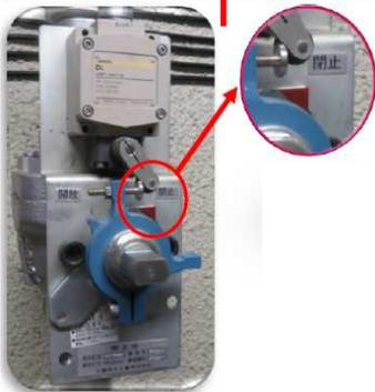
閉止弁とは、消火剤を放射するための配管を閉止するための弁だよ
