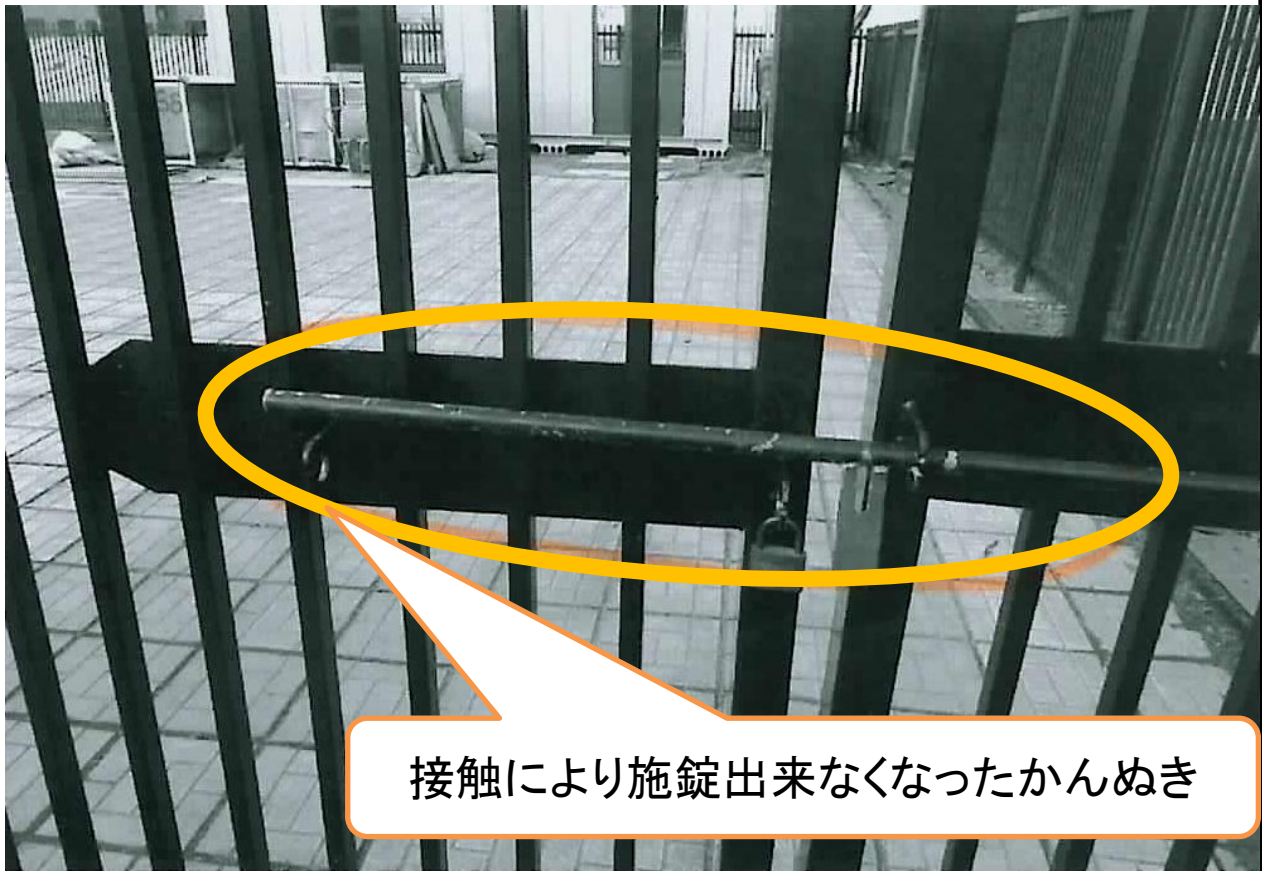
破損箇所(拡大)
