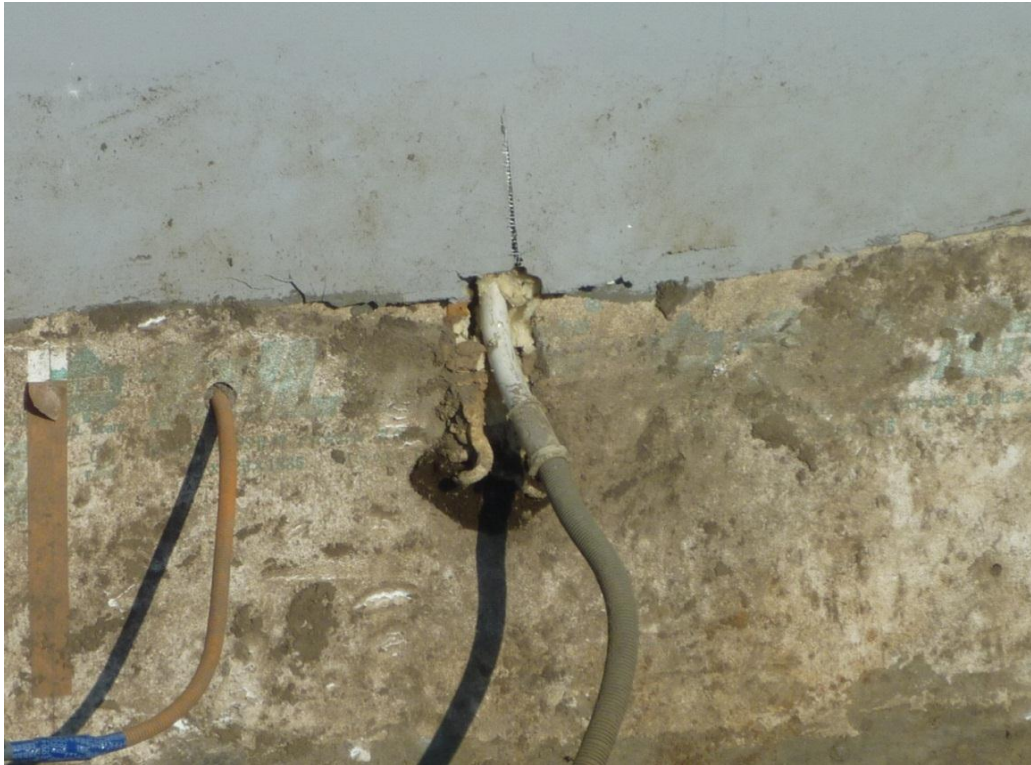
破損箇所(拡大)
