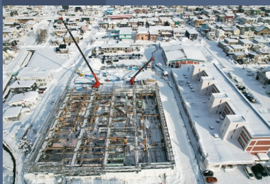
施工中の写真①
