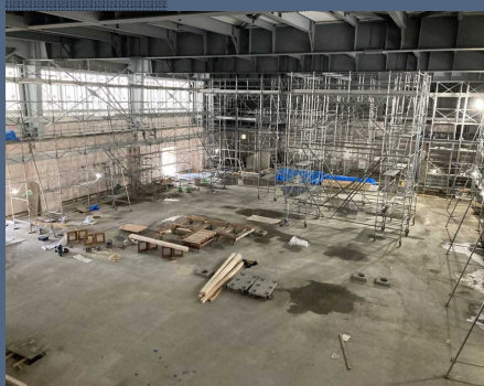
施工写真②
