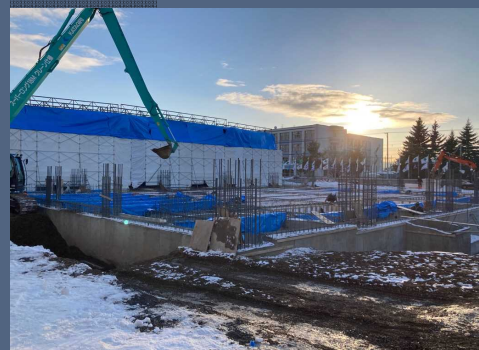
施工写真①
