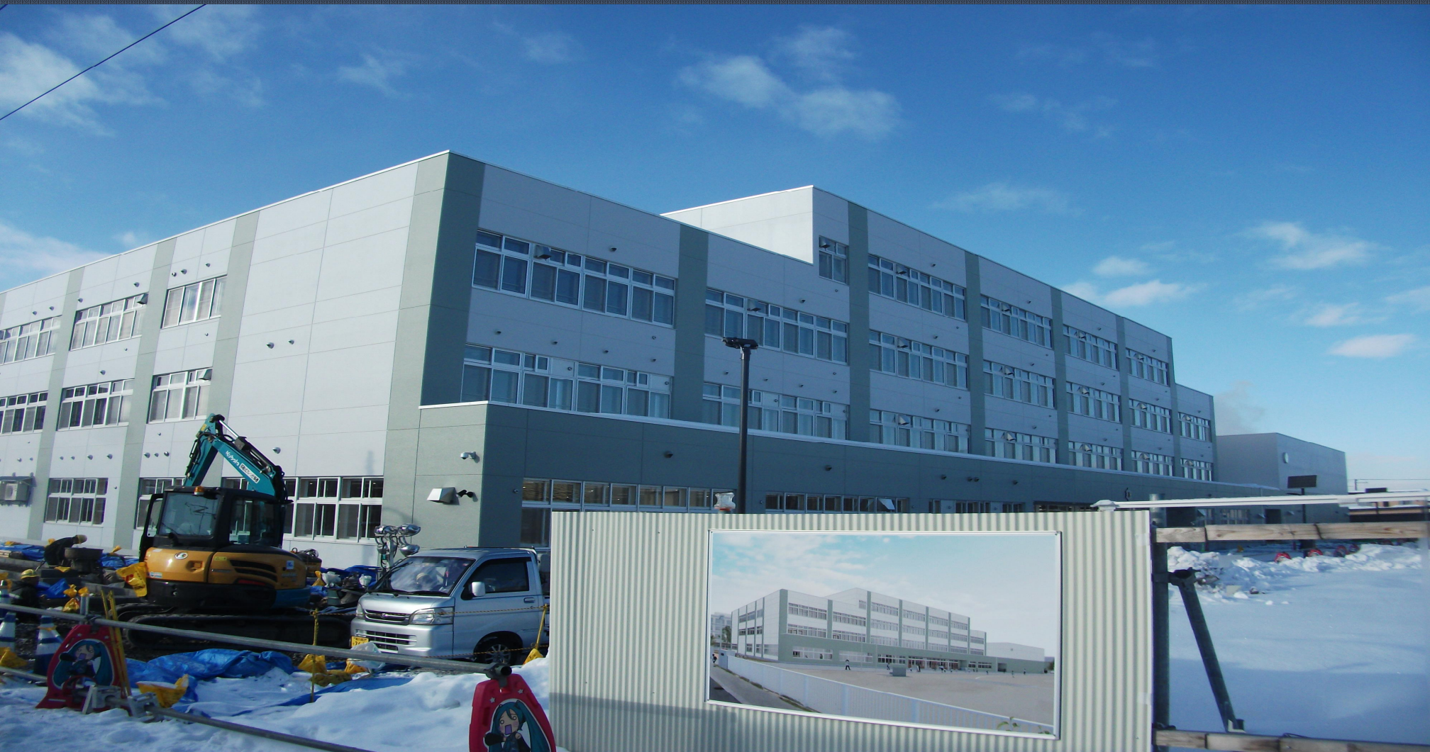
屋内運動場 (体育館)
