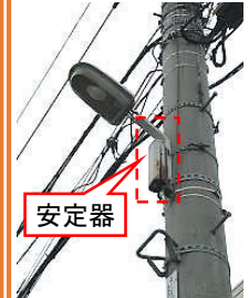
電柱への設置例
