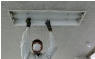
照明器具の反射板を外す
