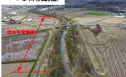
ペーパン川(丸駒橋)
